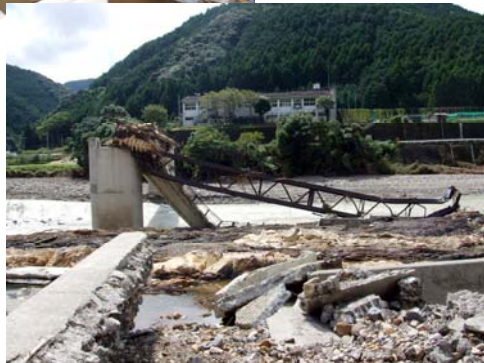
美山小学校 通学用の橋
